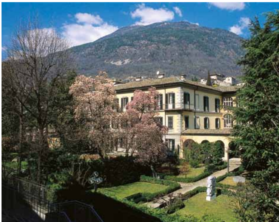
Sondrio. Il giardino e la facciata Sud di Palazzo Sertoli.
