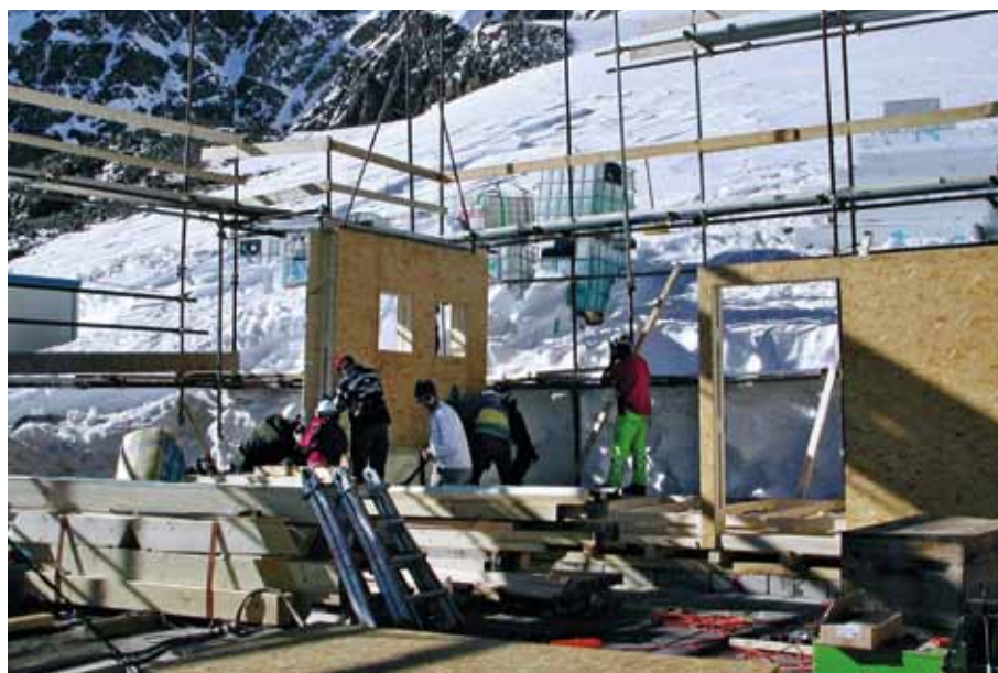
2002 - Rifugio Marco e Rosa De Marchi - Agostino Rocca: una fase del cantiere.
